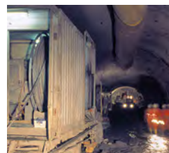
Forage de Tunnels
